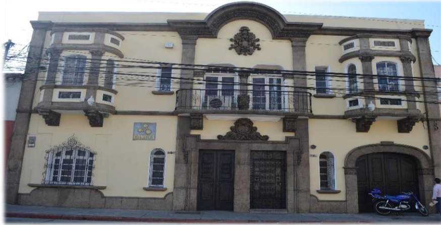
Remozamiento de la Fachada de la sede de la SENACYT. Guatemala, enero de 2017
